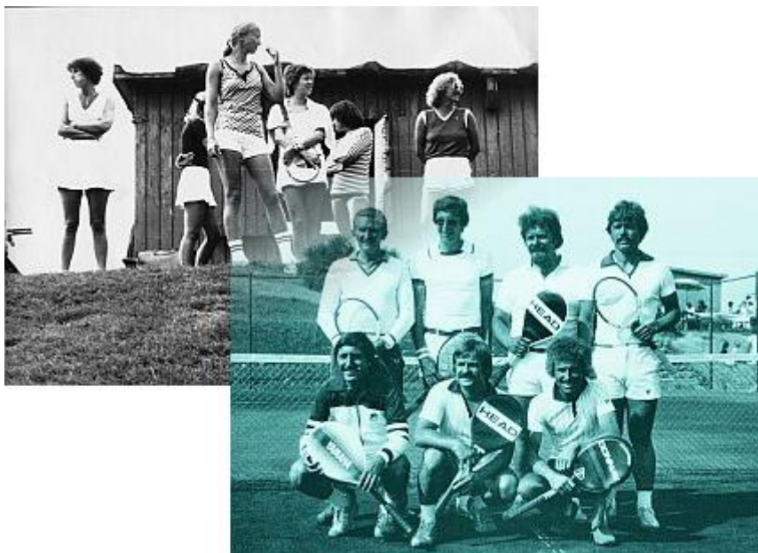
Die Anfänge: Im Hintergrund ist noch die Bauhütte zu erkennen.
